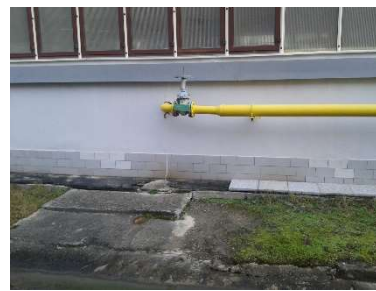
Obrázek 11 - Hlavní uzávěr plynu
